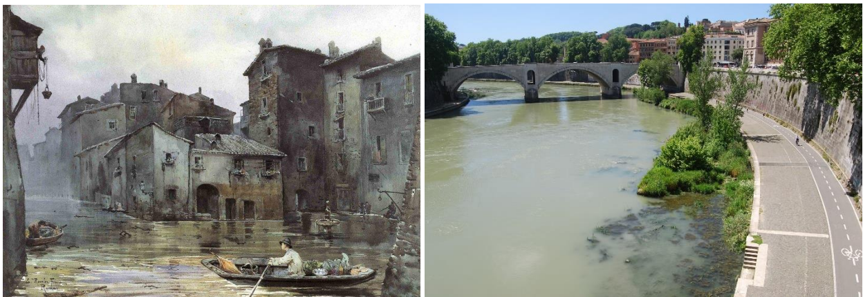
Links: aquarel van Ettore Franz Roesler, net voor de start van de renovatiewerken. Rechts: de huidige toestand.
